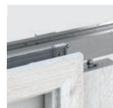
construcția casetei metalice
